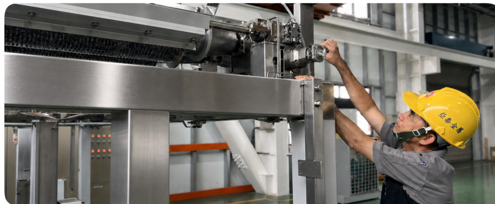
▲ 設備組裝檢查與安全確認
